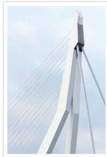
Rotterdam Erasmusbrug close-up 323
